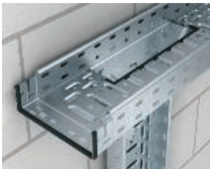
Montáž vestavného odbočného dílu svisle (pohled shora)
