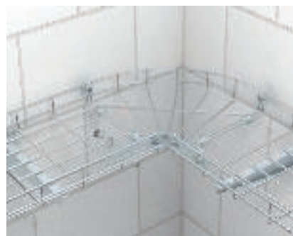
Montáž oblouku mřížového žlabu
