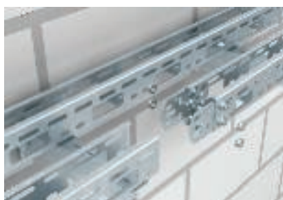
Podélné spojení nosné lišty svítidel
