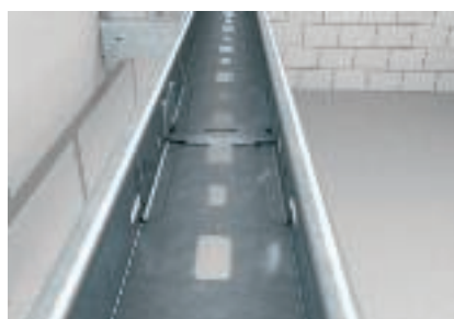
Podélné spojení nosného žlabu svítidel
