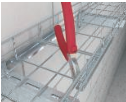
Bezšroubové podélné spojení pomocí rychlospojky
