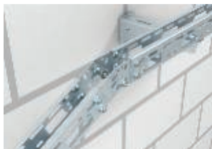
Svislé podélné spojení
