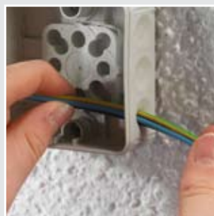
Není nutný žádný nástroj pro děrování vývodky – vodič se jednoduše prostrčí membránou – a je hotovo !
