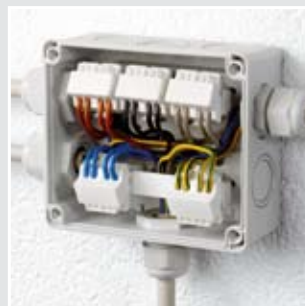
Bezpečný FIXCONNECT®-systém pružinových bezšroubových svorek v DK-kabelových krabicových rozvodkách.
