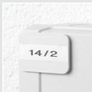
Pomocí visaček lze provést označení obvodů
