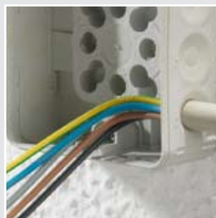
Kabelové vstupy pomocí pružné těsnící membrány ve stěnách rozvodky
