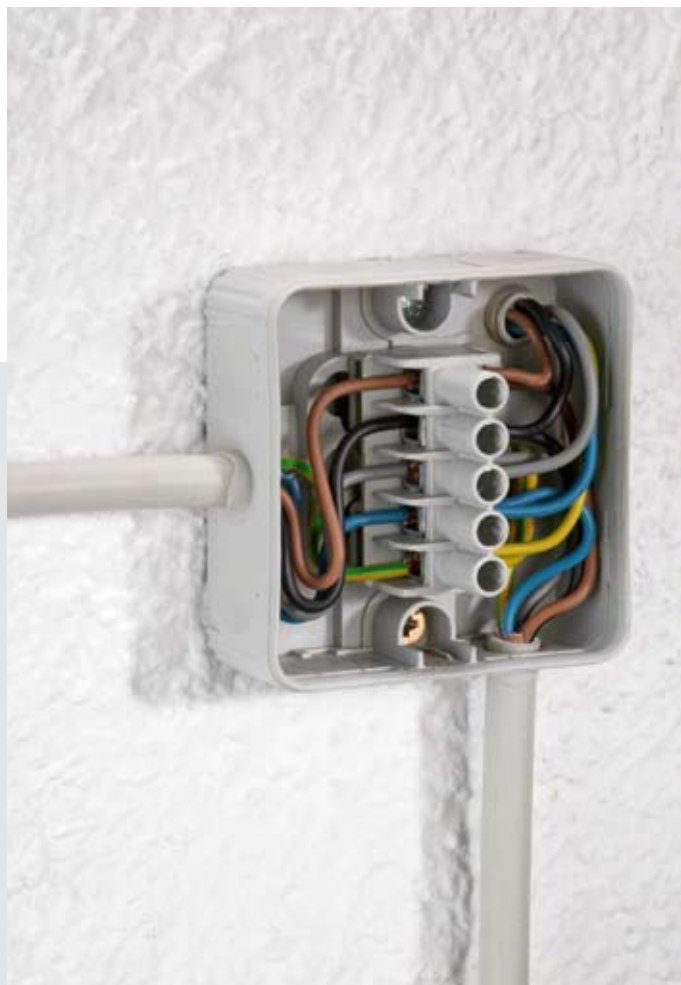
Kabelové vstupy pomocí pružné membrány ve dně rozvodky
